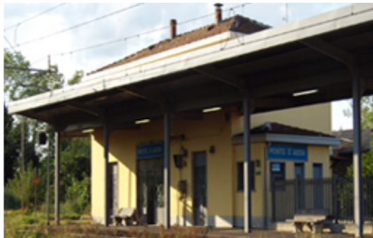
STAZIONE DI PIZZIGHETTONE - PONTE D'ADDA
